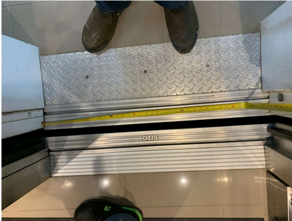
Photo 79 – Door clear width
